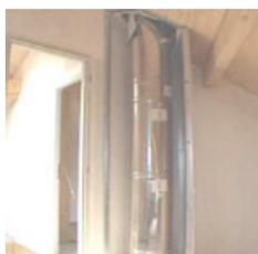
Ecart au feu en plafond C'est la distance entre le conduit et les matériaux combustibles (bois de charpente, planchers ...).
