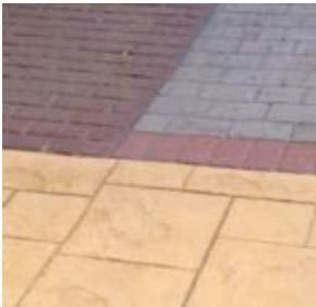
Le béton imprimé est obtenu par application sur le béton éventuellement coloré de moules à l'aspect de pavés ou de dalles. La liberté de conception des formes, des teintes et des aspects de surface permet de structurer l'espace, et d'intégrer harmonieusement les ouvrages réalisés dans l'architecture et le paysage environnants.
