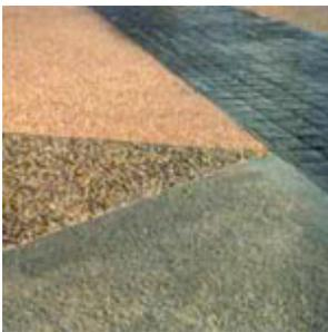
La couleur "naturelle" du béton est déterminée par ses composants. Cette couleur peut être nuancée par l'ajout de colorants, dosés avec précision et ajoutés dans le malaxeur au moment de la fabrication du béton en centrale à béton, pour obtenir un mélange homogène et une teinte dans la masse du béton. La durabilité de la couleur du béton est ainsi garantie sur plusieurs décennies. Les bétons colorés peuvent se décliner dans un grand nombre de teintes.
