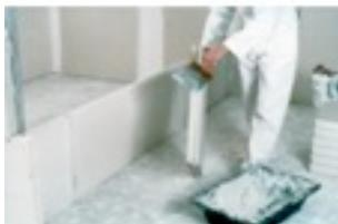
Montage d'une cloison en carreaux
