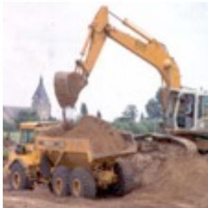
**Le terrassement** correspond à l'ensemble des travaux modifiant les formes naturelles du terrain en vue de la réalisation de la maison. Il consiste dans l'excavation nécessaire pour des parties en sous-œuvre (cave, sous-sol enterré, tranchées de canalisations) et en remblais (terrasses).
